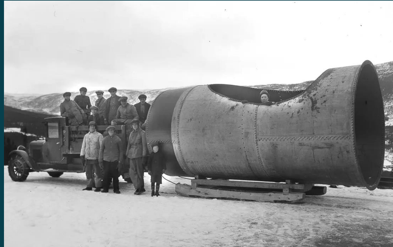
Lastebil frakter rørgate – Hol-utbyggingen. Hallingdal, 1952
