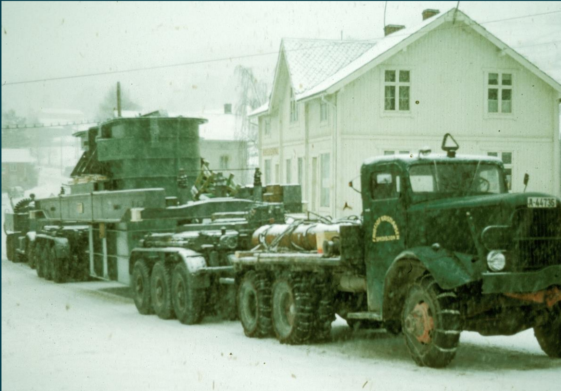
Traktor frakter transformator – Hemsil-utbyggingen. Hallingdal, 1959
